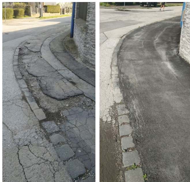
Stav pred a po oprave chodníkov.
